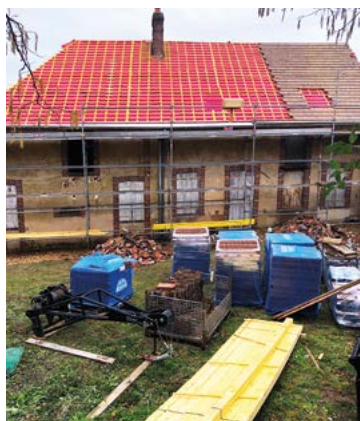
Ci-contre : travaux à la maison Larcena. Photo F. Richez.
